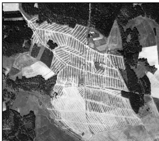
Letecký snímek z budování drenážního systému na lokalitě Hesiny (1966)
