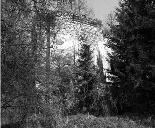
Potrubí vedlo po pravé straně cesty, prošlo pod cestou a zatočilo se pod ruiny kostela.
