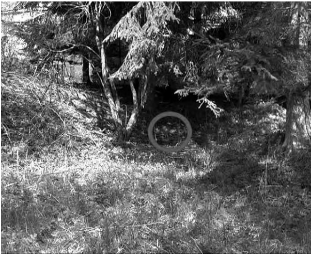
V těchto místech vniklo potrubí do podzemí kostela.
